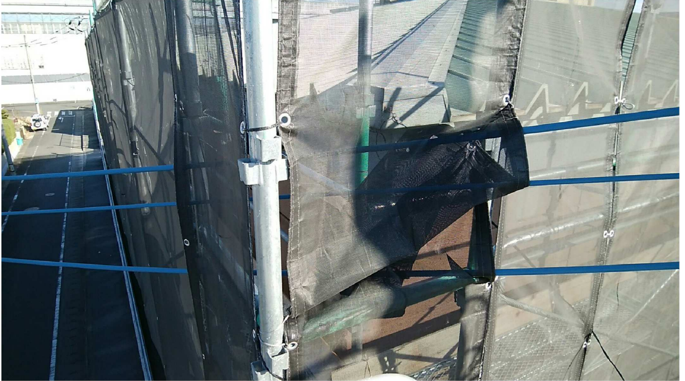
足場貫通箇所拡大部（防護実施前）
