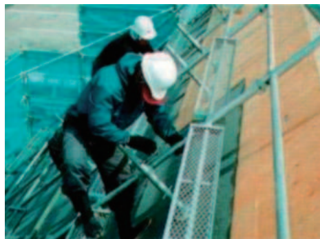
図2-6 屋根足場の例
